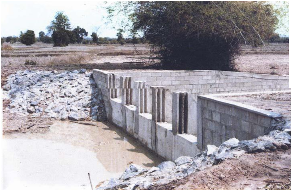
รูปที่ 2.7 แสดงฝายทดน้ำขนาดเล็ก ( ฝายมาตรฐาน มข.2527)
