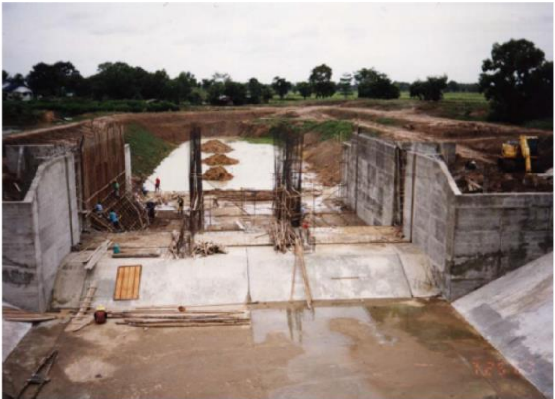
รูปภาพแสดงโครงการสร้างเสริมเหล็กฝาย มข.
