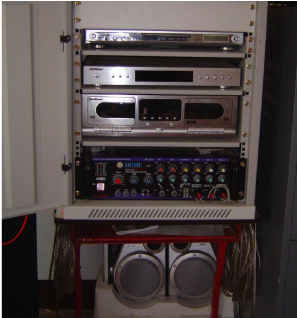
ภาพที่ 2.3.1 ข การติดตั้งอุปกรณ์ในตู้อุปกรณ์ (RACK) เรียงตามลำดับจากชั้นล่างสุด เครื่องขยายเสียง เครื่องเล่นเทป จูนเนอร์ และ เครื่องเล่นซีดี
