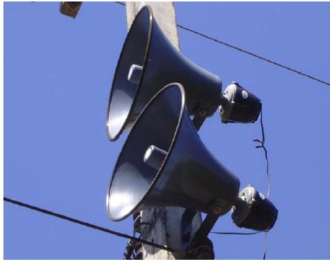
ภาพที่ 2.3.1 ช การติดตั้งลำโพงของระบบเสียงตามสายภายในหมู่บ้านหรือชุมชน
