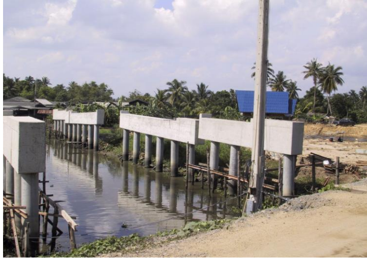
รูปที่ 4-13 คานหัวเสา
