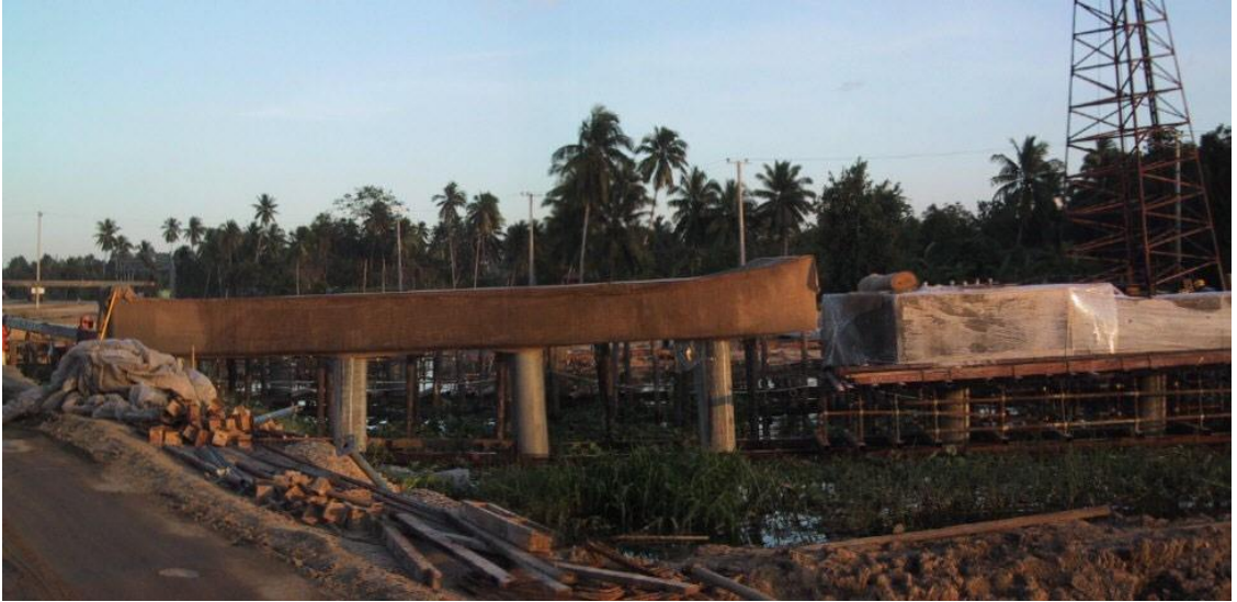
รูปที่ 4-7 การบมคอนกรีตโดยไ้กระสอบหรือพลาสติก
