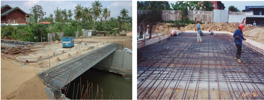
รูปที่ 4-15 การผูกเหล็กและการหล่อแผ่นพื้นสะพาน
