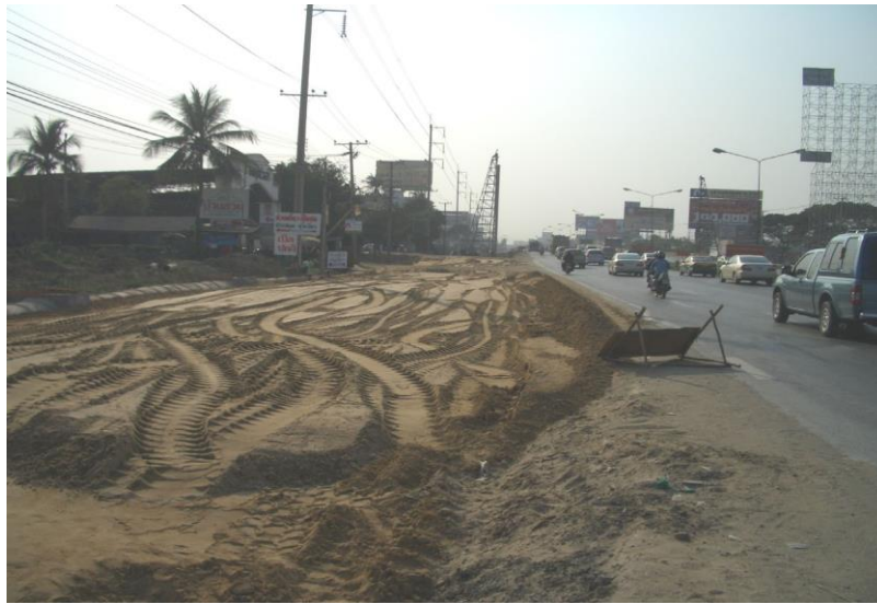
รูปที่ 4-17 งานถมทรายและบดอัดบริเวณคอสะพาน
