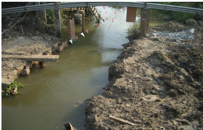
รูปที่ 4-1 สภาพรอน้ำที่จะก่อสร้างสะพาน
