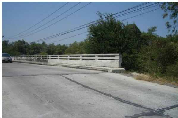
รูปที่ 4-16 ช่วงคอสะพานที่ไม่มีการตอกเข็มพิต
