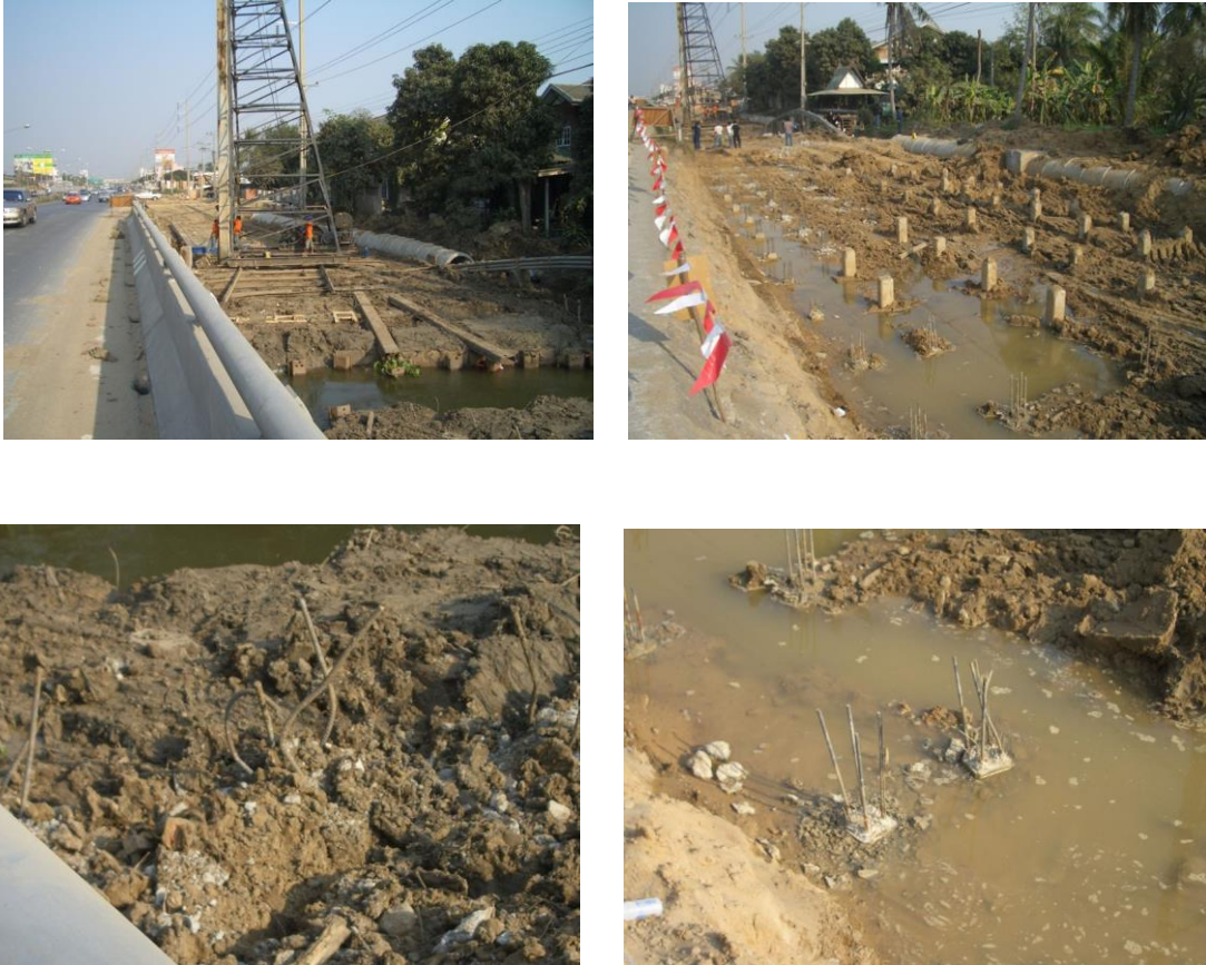
รูปที่ 4-11 การตอกเสาเข็ม ฐานรากและการสกัดหัวเข็ม
