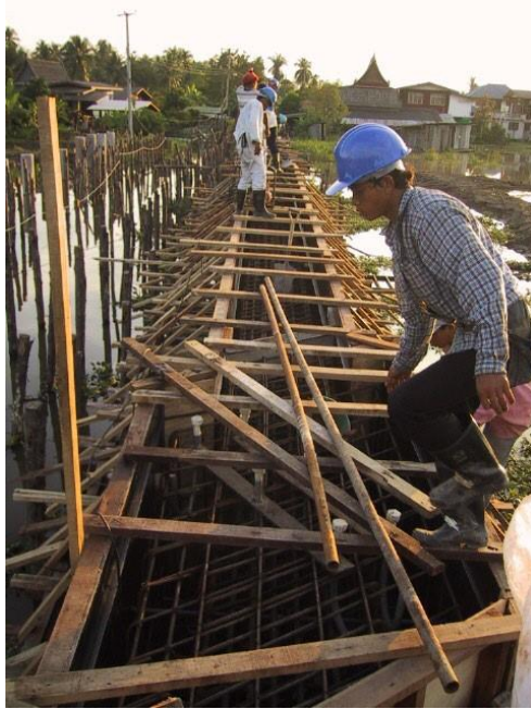
รูปที่ 4-8 การตรวจสอบแบบหล่อคอนกรีตใ้ลอยตามแบบก่อสร้าง
