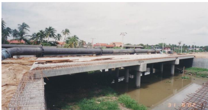
รูปที่ 4-12 เสาตอมอดับริมและเสาสะพาน
